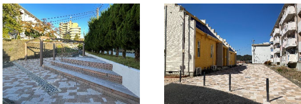
Fig.3. Completed Exterior Space (完成した外部空間)
